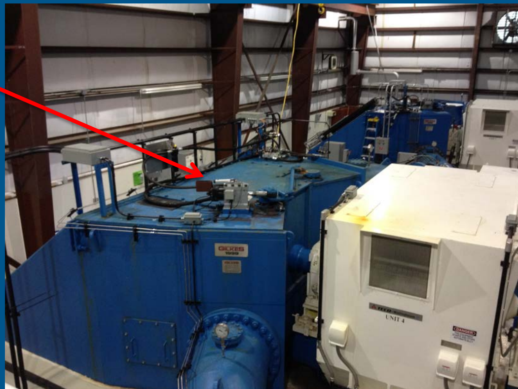
3MW hydro turbine, Cordova, AK.
